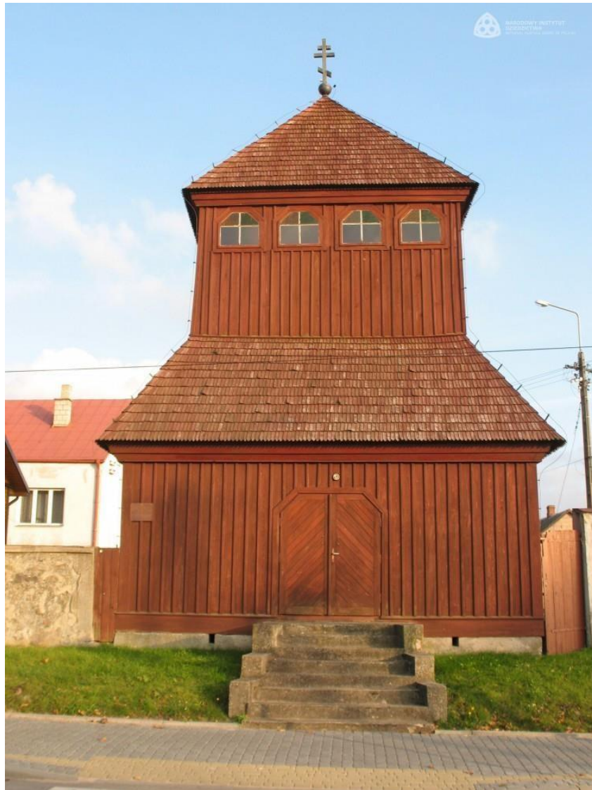
Fot. 2. Drewniana dzwonnica, Kleszczele
