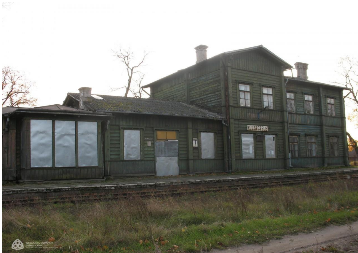
Fot. 1. Dworzec kolejowy, Kleszczele
